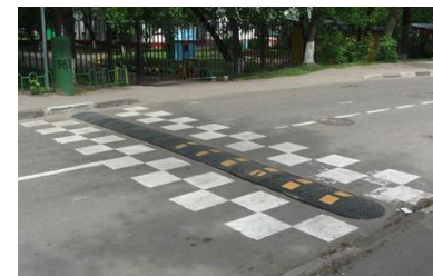
Рисунок 1.3 – Пример исполнения искусственной неровности сборно-разборной конструкции
