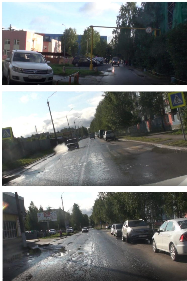
Рисунок 8.2 – Неудовлетворительное состояние ТСОДД (некорректно установленный дорожный знак, плохо различимая дорожная разметка)
