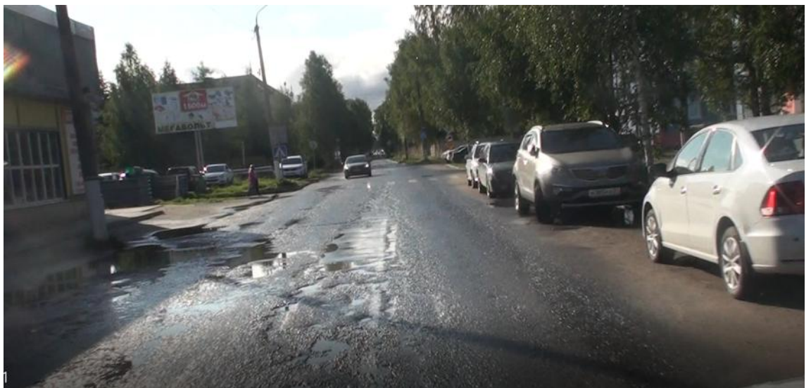
Рисунок 8.2 – Неудовлетворительное состояние ТСОДД (некорректно установленный дорожный знак, плохо различимая дорожная разметка)
