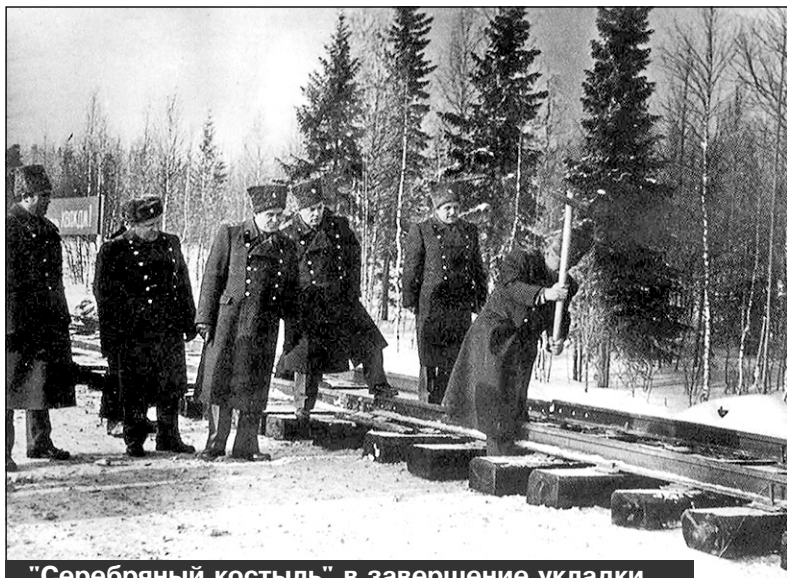
"Серебряный костыль" в завершение укладки железнодорожного полотна на опытной ветке для испытаний БЖРК
