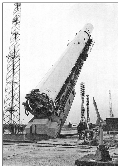
Установка РН "Циклон-3" на стартовый стол
