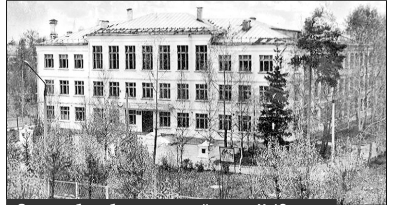
Здание общеобразовательной школы №12. Открыта 1 сентября 1960 года
