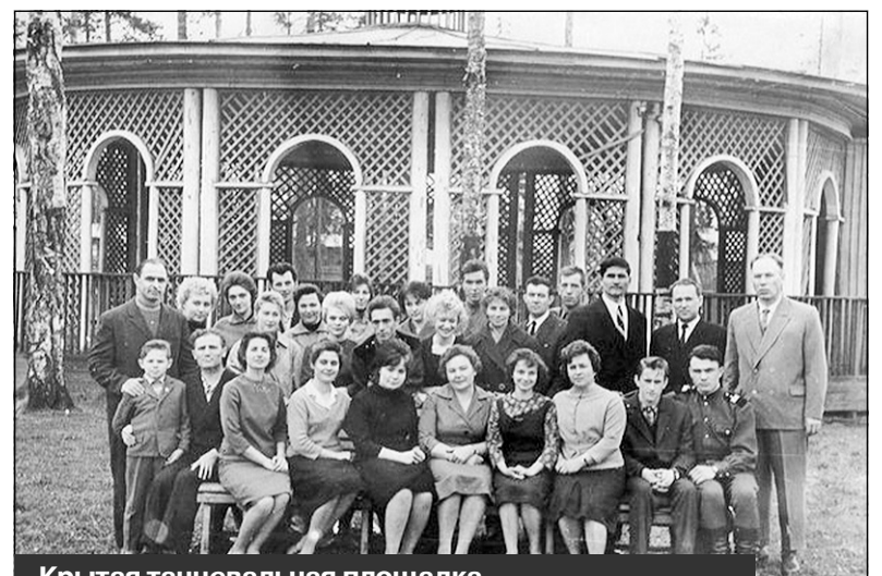
Крытая танцевальная площадка. Располагалась за клубом войсковой части на улице Мира. Фото 1960-х годов
