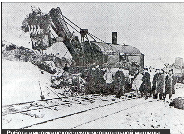
Работа американской землечерпательной машины на строительстве участка Плесецкая - Обозерская. Фото 1895 года
