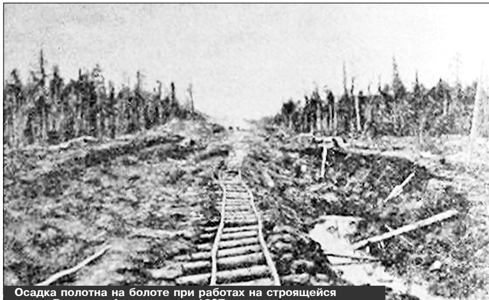
Осадка полотна на болоте при работах на строящейся линии Вологда - Архангельск в 1897 году
