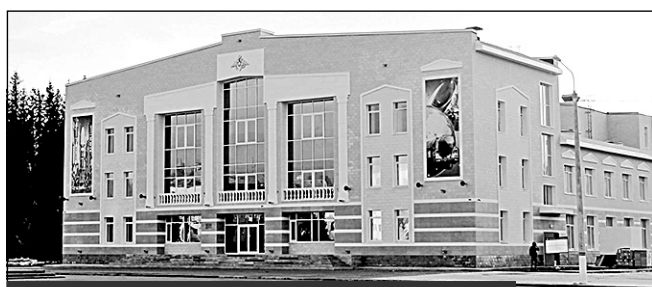
Избирательный участок № 545, г.Мирный, ул.Ленина, 22, Дом офицеров гарнизона
