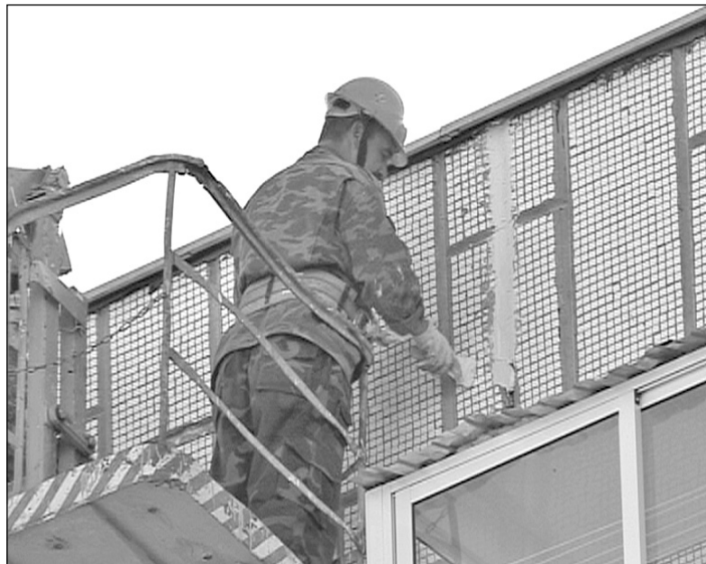
На фото: Заделка межпанельных швов
