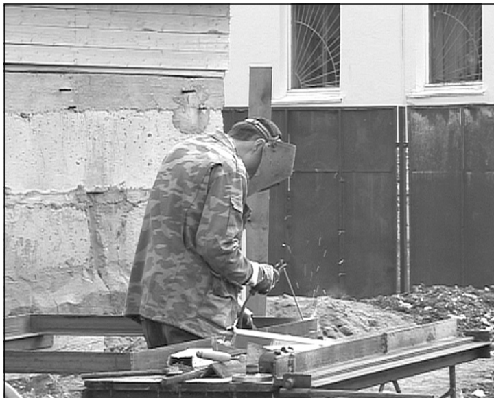
На фото: Работы продолжаются
