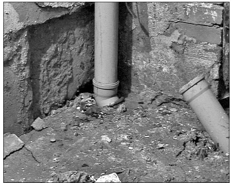
На фото: Чтобы устранить засор, часть канализационного трубопровода в подвале дома пришлось разобрать.
