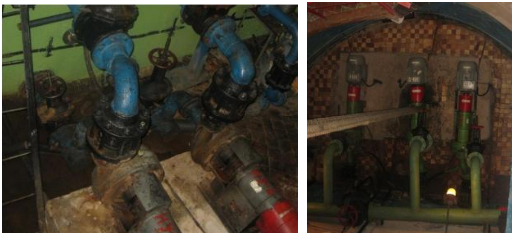
Рис. 2.1.7. Примеры обвязки насосов КНС
