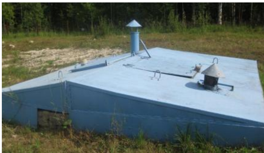
Рис. 1.1.6. Вид насосной станции 1 подъема
