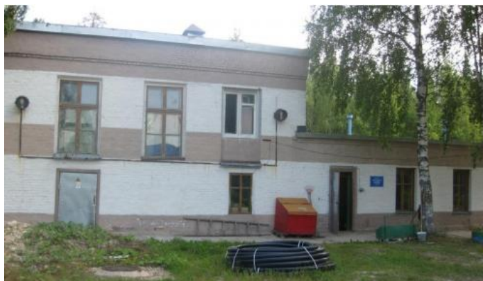
Рис. 1.1.9. Общий вид насосной станции II подъема
