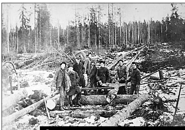
Спецпереселенцы на строительстве лесовозной дороги. Северный край. Фото 1930-х
