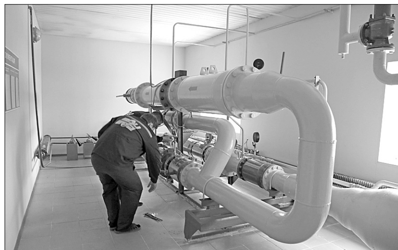
На фото: МУП «ЖЭУ». Замена манометра на газовом распределительном устройстве в городской котельной
