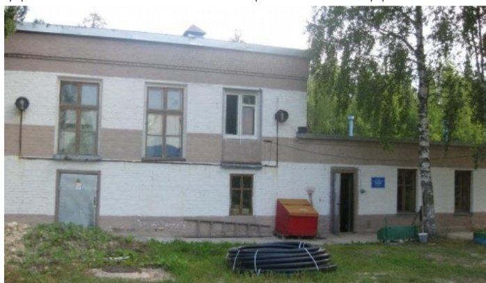
Рис. 1.1.9. Общий вид насосной станции II подъема
