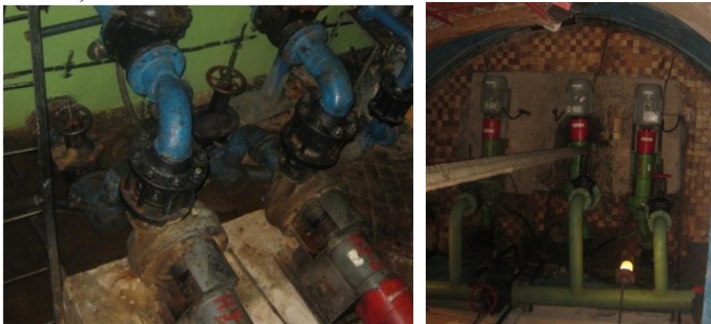
Рис. 2.1.7. Примеры обвязки насосов КНС
