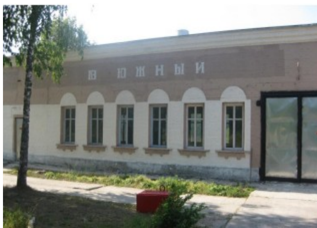
Рис. 1.1.7. Общий вид насосной станции II подъема ВЗК «Южный»
