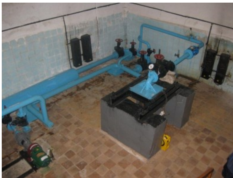
Рис. 1.1.4. Водозаборный комплекс очистных сооружений
