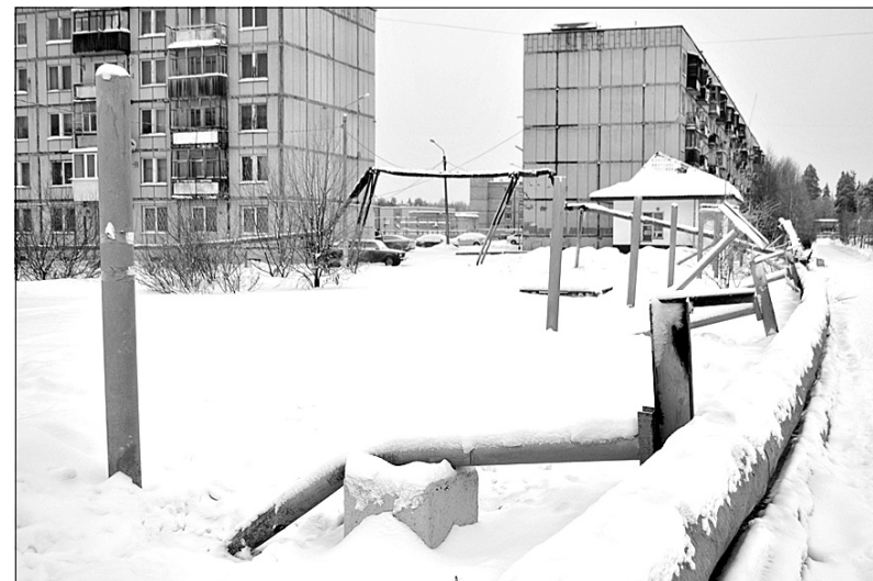
На фото: На переднем плане сломанная стойка – в нее врезался трактор и запустил «цепную реакцию»
