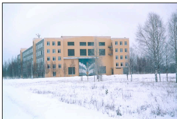
Рисунок 1.10 - Монтажно-испытательный корпус (соор. 1) на площадке 142
