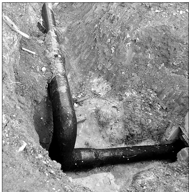
Для врезки этих новых труб в водопроводную систему Мирного и отключали воду
