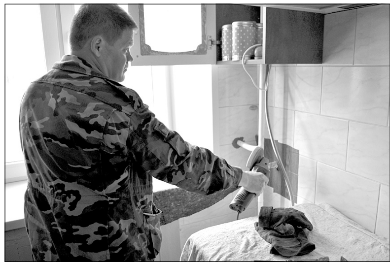
На фото: демонтаж старого вводного газопровода в одной из квартир дома № 61 по ул. Ленина
