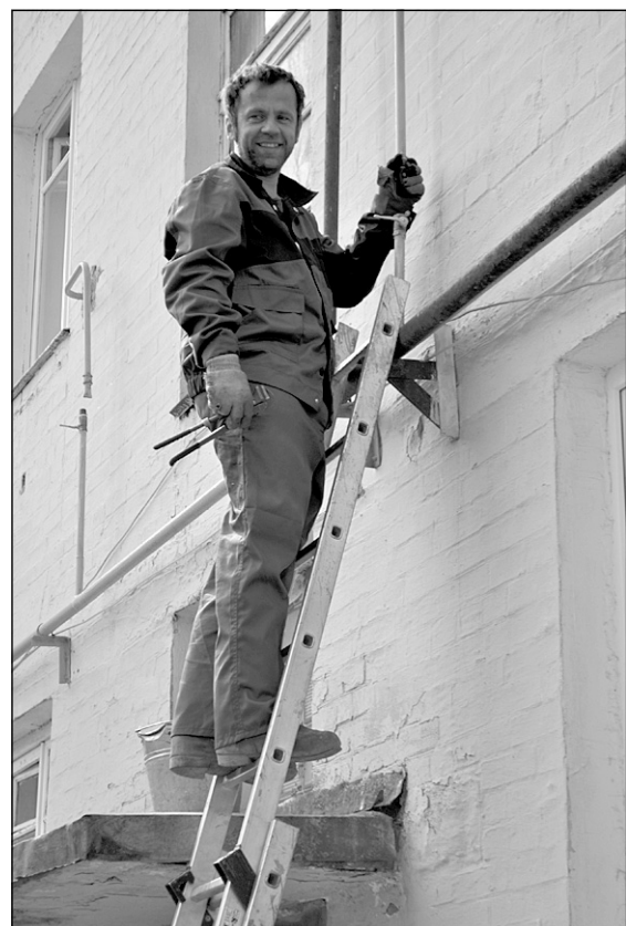
На фото: подготовка внешней системы к пуску газа
